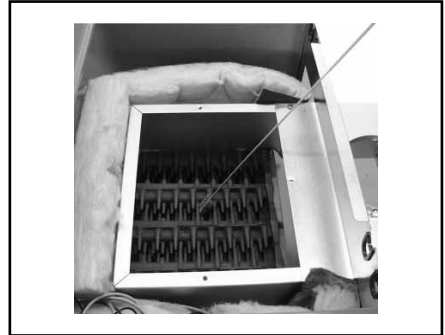
Bild: Reinigung Rauchgaszüge
