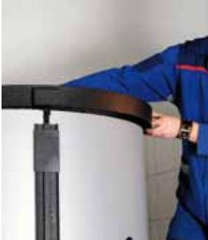
Abnehmen des Speicherdeckels und der oberen Ronde. Abziehen der Rosetten an den Anschlüssen. Verschlussleiste auseinander haken und die Speicherverkleidung abnehmen.
