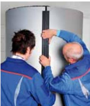
Die Ronde oben am Speicher einlegen und durch leichtes Andrücken positionieren. Um eine optimale Wärmedämmung zu erlangen, darf zwischen Ronde und Mantel-Wärmedämmung kein Luftspalt vorhanden sein. Deckel mit den Hakenleisten-Ausnehmungen oben auf der Wärmedämmung richtig positionieren und anbringen.
