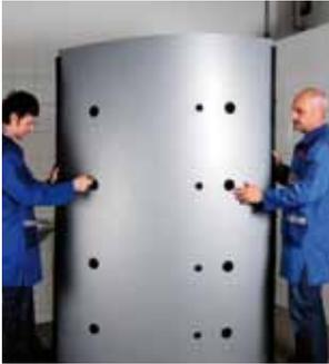
Die Wärmedämmung mit dem Vlies nach innen über die Anschlüsse aufziehen und die Hakenverschlussleiste einrasten. Um ein Öffnen der Hakenverschlussleiste während des weiteren Montagevorganges zu verhindern, sollten die Abdeckmontageleisten an der Hakenverschlussleiste angebracht werden.
