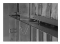
Die Taschenfilter sind mit Clips am Taschenfilteraufnahmerahmen befestigt. Zum Wechseln Clips lösen und Taschenfilter zur Staubluftseite herausnehmen. Die Taschenfilteraufnahmerahmen sind mit einer geschäumten Dichtung versehen.
