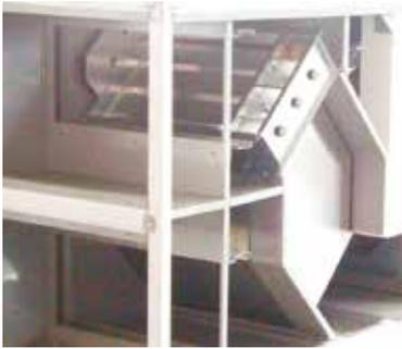
Der Gegenstrom-Plattenwärmetauscher ist grundsätzlich wartungsfrei. Bei Inbetriebnahme prüfen, ob der Stellmotor für die Bypass-Klappe die richtige Drehrichtung aufweist (Bypass-/WRG-Betrieb).
