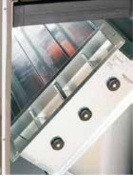
Klappen auf Leichtgängigkeit prüfen. Klappen nicht ölen. Der verwendete Kunststoff kann dadurch zerstört werden und die Funktion der Klappe ist nicht mehr gegeben.
