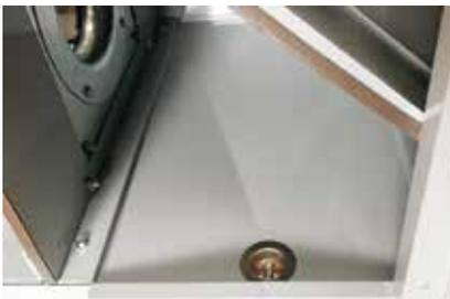
An den beiden Kondensatabläufen ist je ein Siphon vorzusehen und das Kondensat in die Kanalisation abzuleiten.
