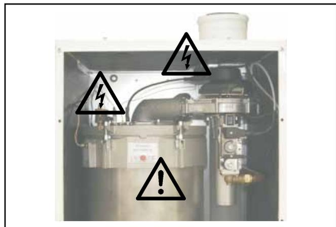
Bild: Zündtrafo, Hochspannungs-Zünder, Wärmetauscher
